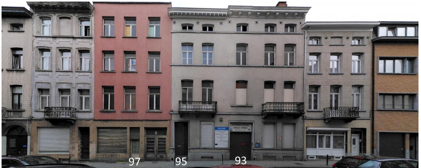
Photo des façades de la rue Piers dans leur contexte
