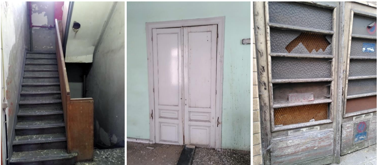
Cage d'escalier, porte intérieure et porte cochère du numéro 97
