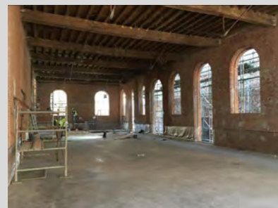
Rénovation de la Tour à Plomb avec des briques de réemploi, in situ, à Bruxelles, conception: BEAI Photos: Bernard Van Damme
