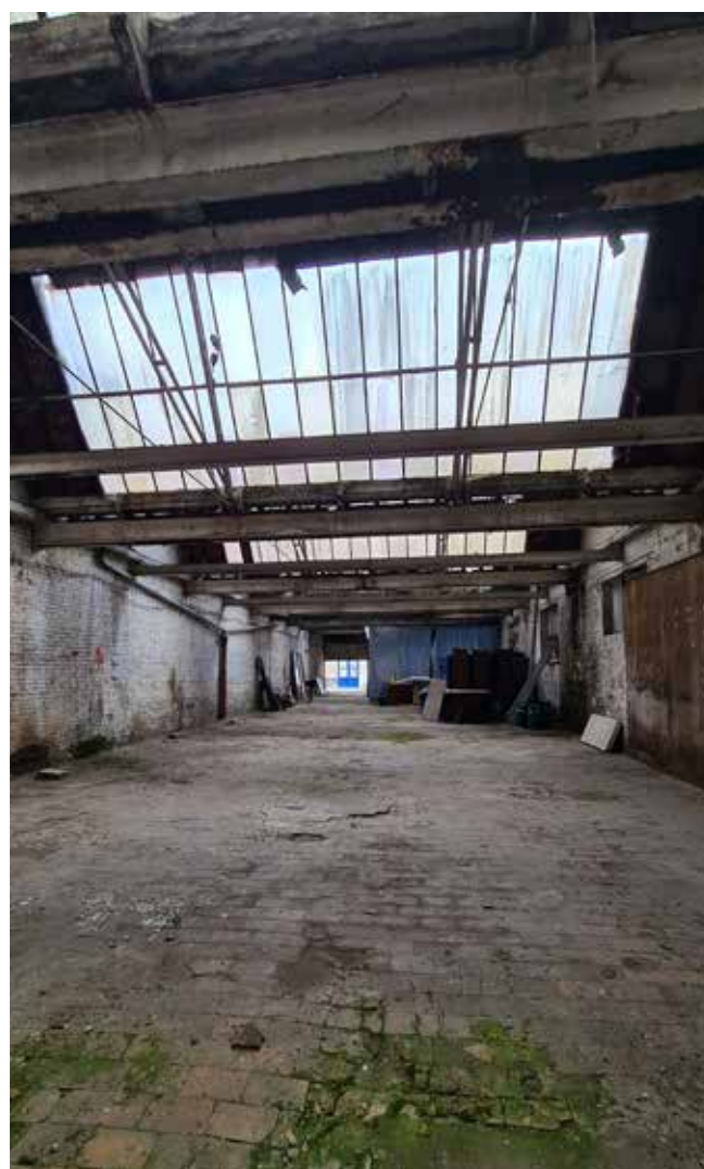
Bâtiment adjacent en shed. Aangrenzend schuurtje.
