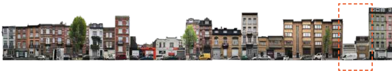
Rue d'Ostende 92 Oostendestraat 92
