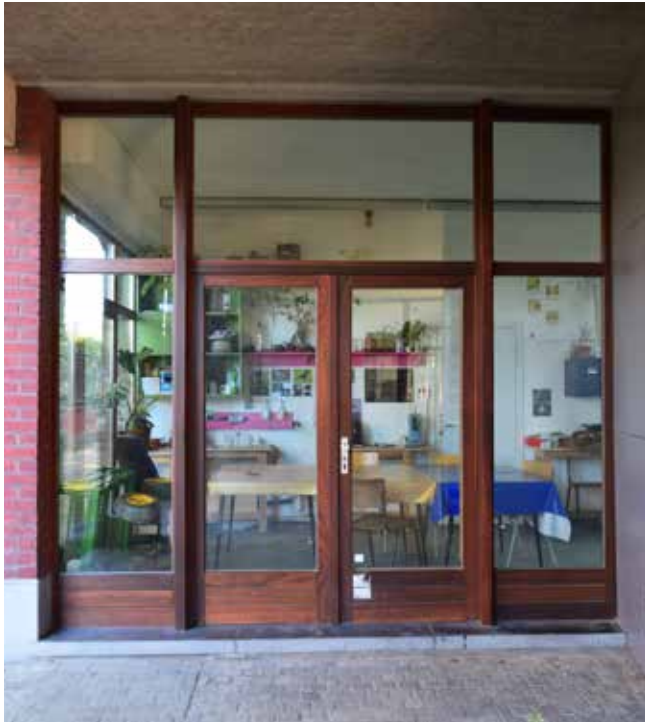
Local de quartier parc Reine-Verte - Schaerbeek
