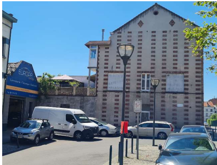
Façade côté place Van Hoegarde et entrée atelier
