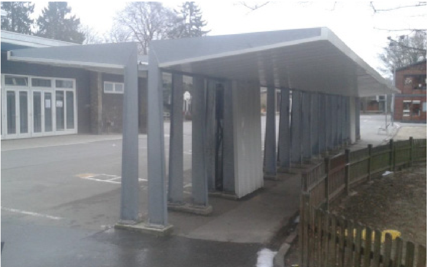
Photo 5: préau à démolir
