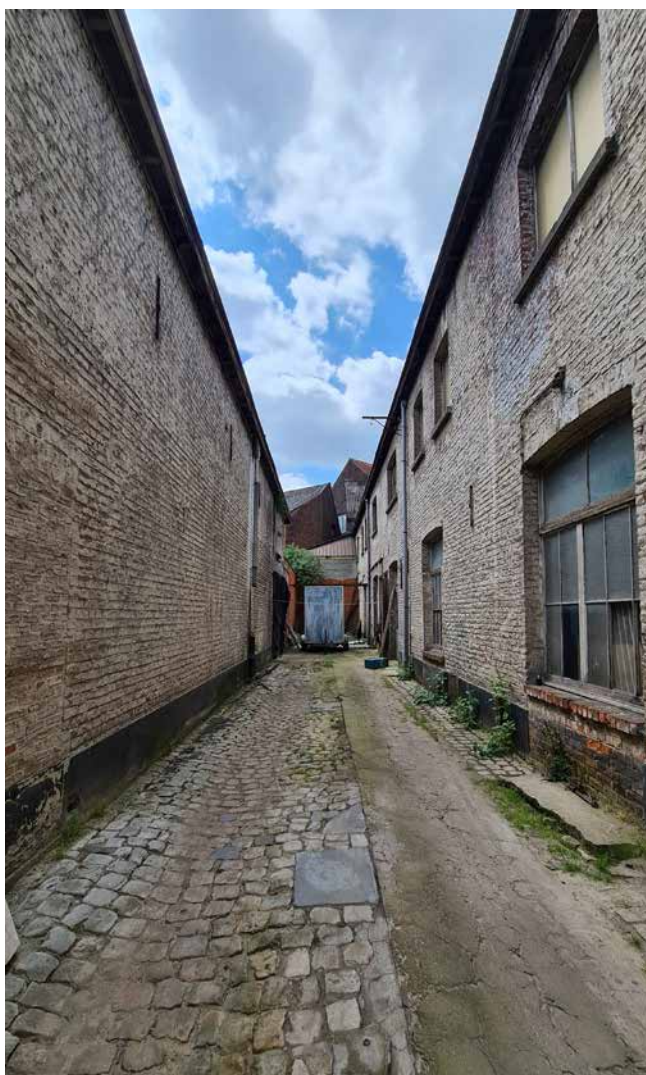
Façade sur la ruelle et intérieur d'îlot
