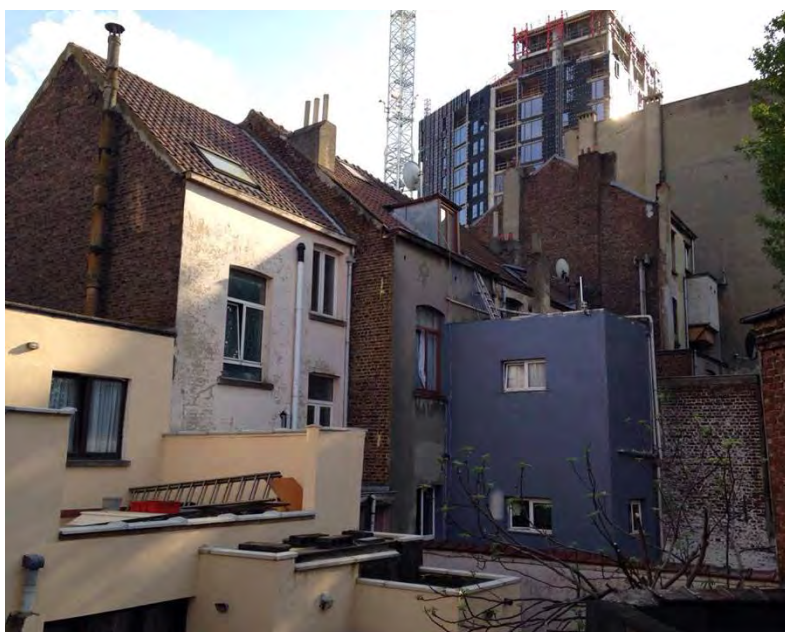
INTERIEURS D'ÎLOTS ENTIÈREMENT CONSTRUITS BINNENTERREINEN ZIJN VOLGEBOUD
