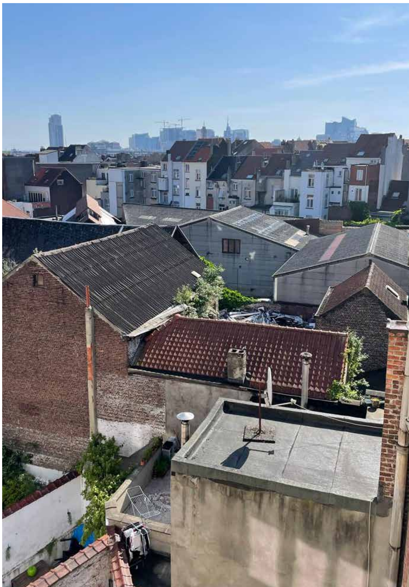
L'îlot vu d'une toiture de la rue de la Carpe.
