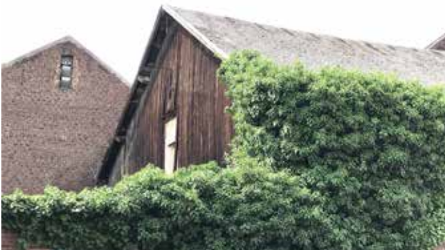
Façade avant du bâtiment industriel en intérieur d'îlot, 2023.
