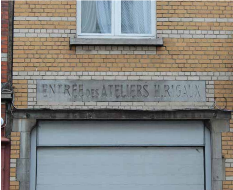
Ateliers Henri Rigaux, rue d'Ostende 74. Photo prise en Avril 2023.
