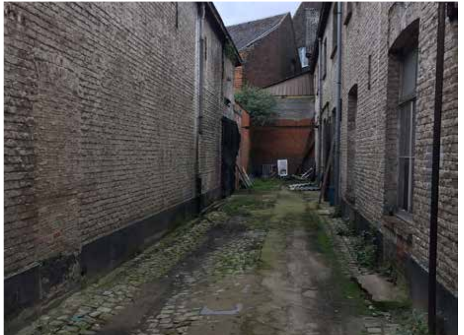
Photo de l'intérieur de l'îlot, mai 2023.
