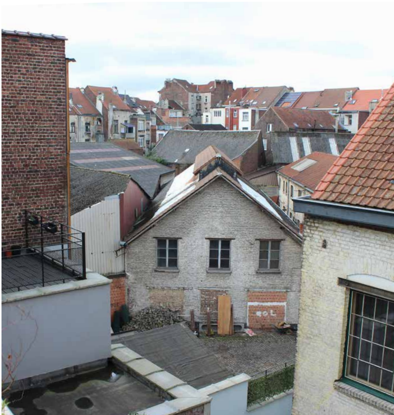
L'îlot vu d'une toiture de la rue de la Carpe.
