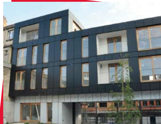
L'ancien bâtiment situé à la rue Le Lorrain, 6 - 8 a été entièrement rénové pour y accueillir 7 nouveaux logements sociaux (4 appartements et 3 petites maisons)
