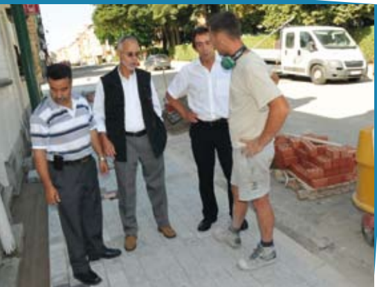
De gauche à droite: El Mostapha Cherkaoui, Inspecteur-gestionnaire des chantiers; Mohamed Daif, Echevin des Travaux publics; Christian Kolp, responsable des Travaux publics et un ouvrier à la rue Osseghem
