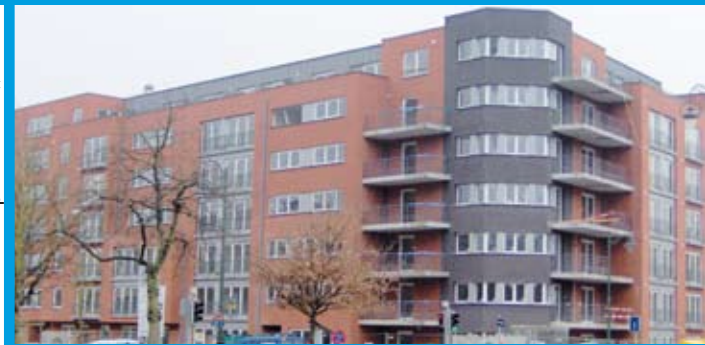
Ensemble de nouveaux logements à l'angle du bld Mettwewie - rue du Scheutbos)
