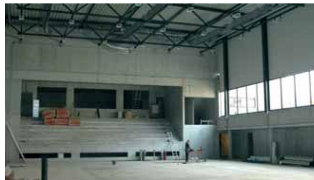
Nouveau hall sportif à la rue Beudin
