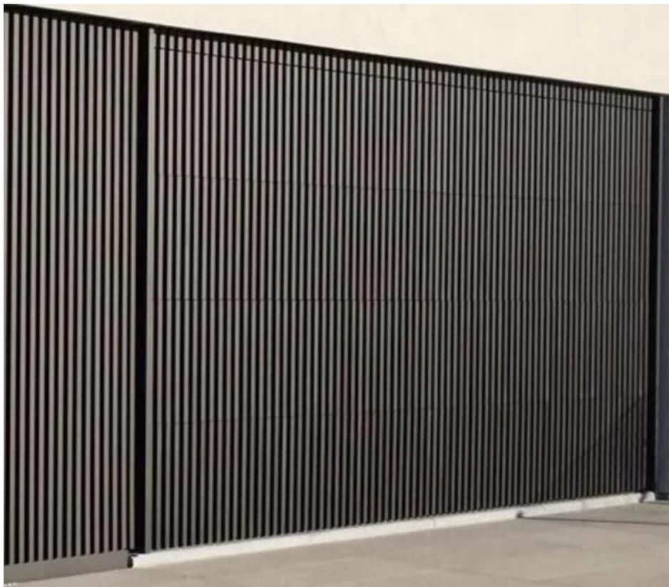
Le résultat fait que le bardage qui recouvre la porte sectionnelle est dans le même plan que celui qui recouvre la façade. Les joints sont réduits au minimum 5mm et les découpes du bardage suivent les dimensions des panneaux isolés.
