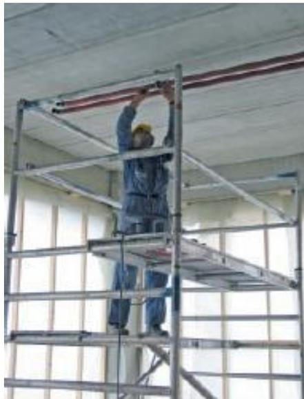
Le fabricant de l'échafaudage roulant ou une personne compétente désignée par l'employeur doit établir une note de calcul et des instructions pour le montage et l'utilisation d'un échafaudage roulant.
