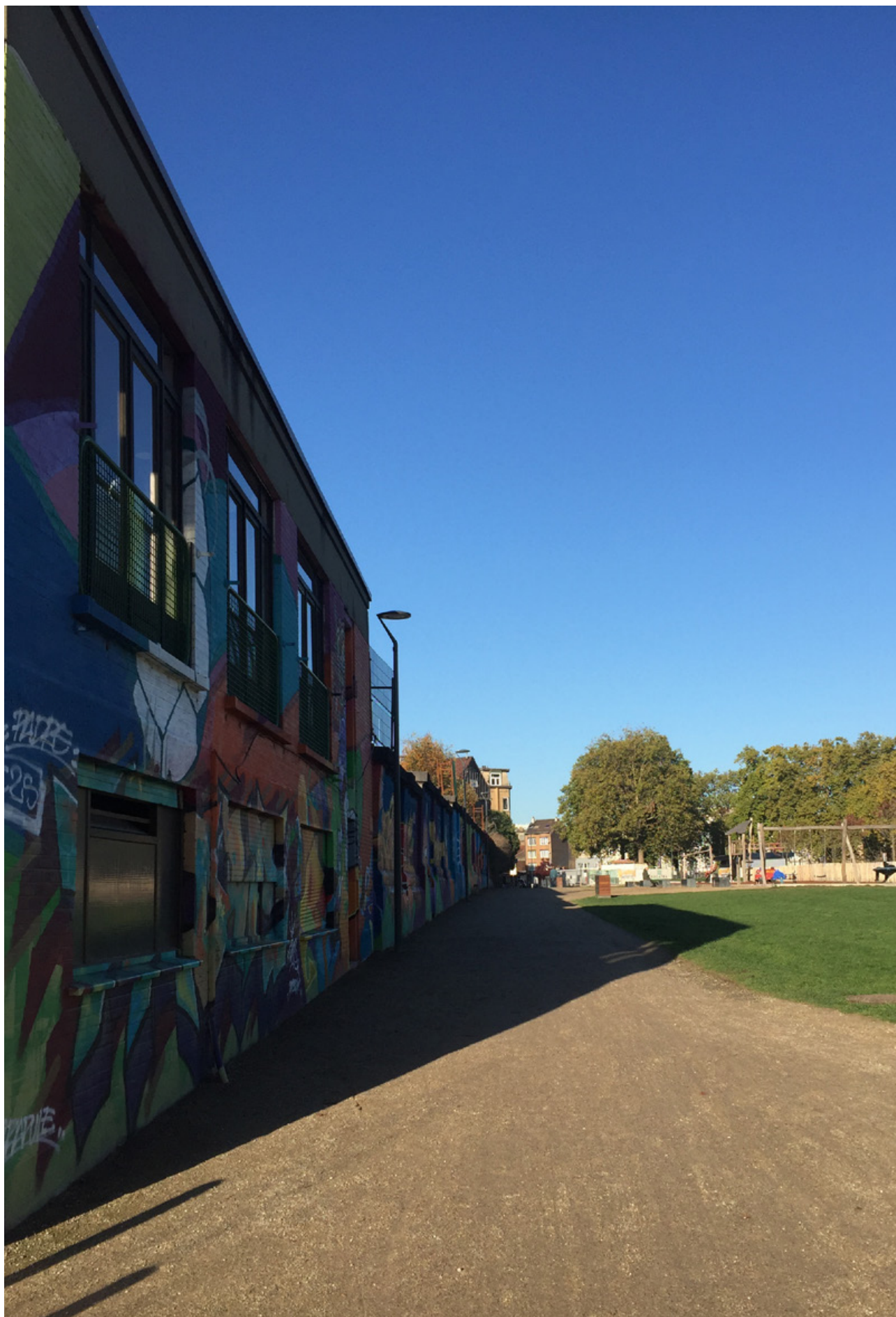
↑ Het huidige Vander Puttenstadion
