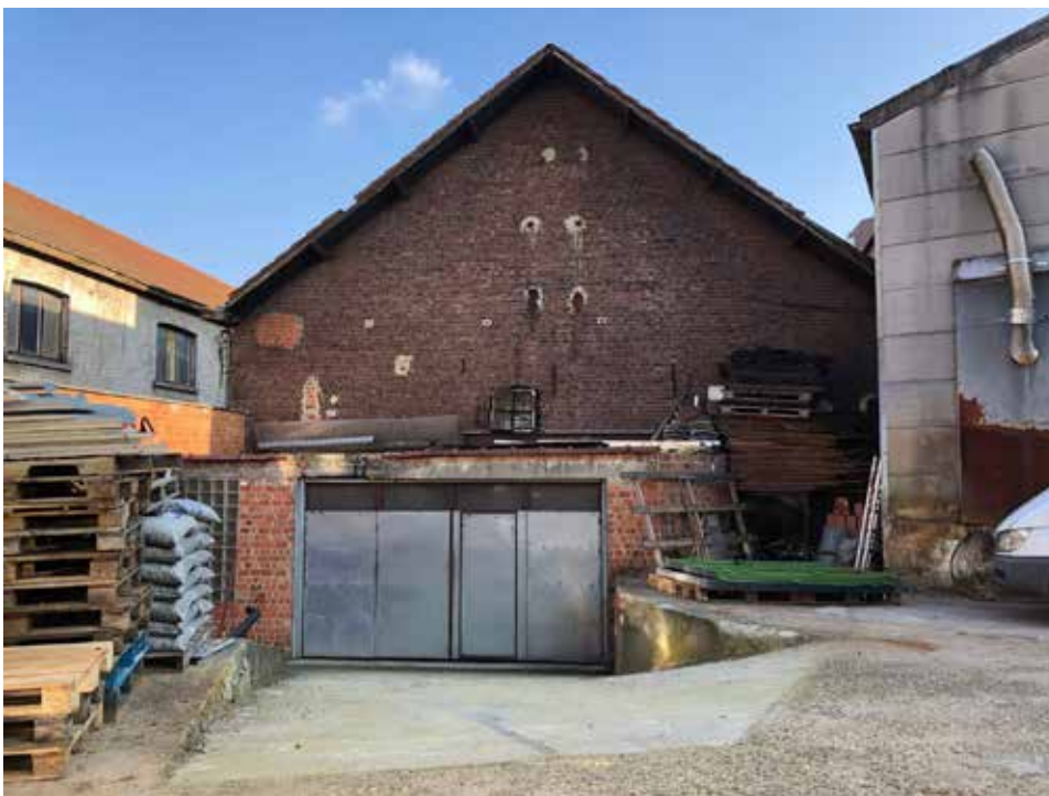
Façade de l'atelier en brique, 2023. Voorkant van de atelier met bakstenen, 2023.
