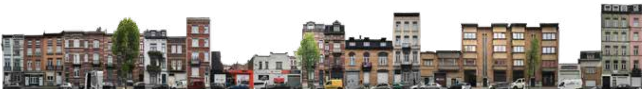
RUE D'OSTENDE - OOSTENDESTRAAT
