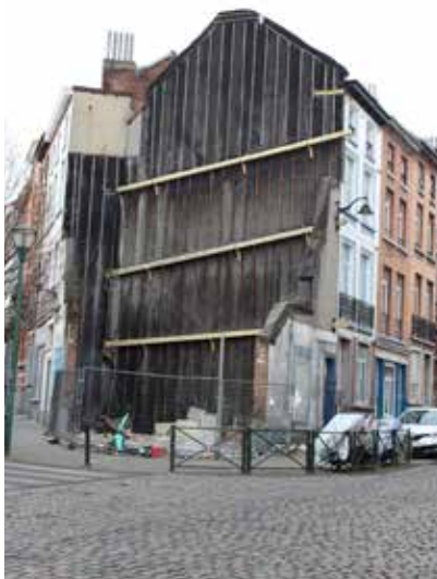
Photo de la dent creuse entre la rue d'Ostende et la rue de la Carpe, mars 2023.
