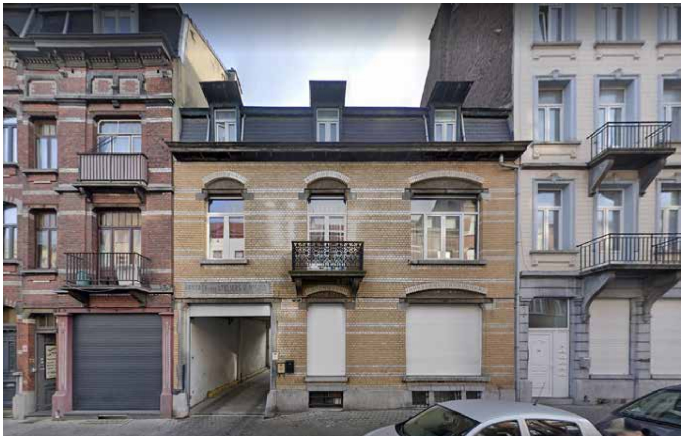
Façade avant actuelle, 2023.
