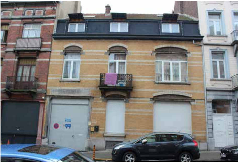
Photos du bâtiment situé dans la rue d'Ostende 74.
