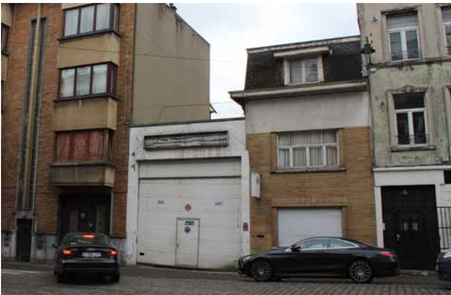
Photos du bâtiment situé dans la rue d'Ostende 92.
