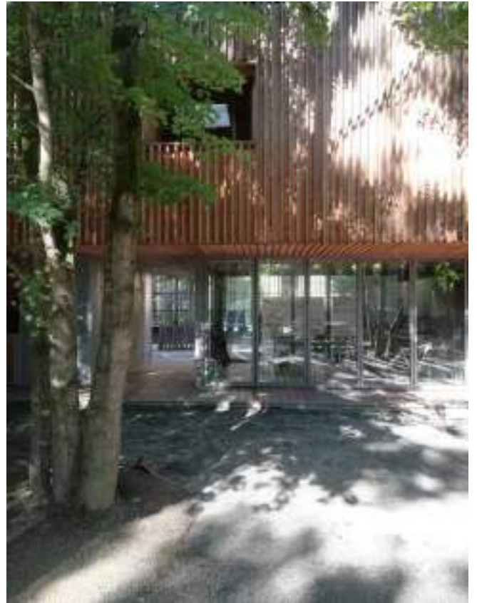
Local de quartier et sanitaires Parc Liedekerke
