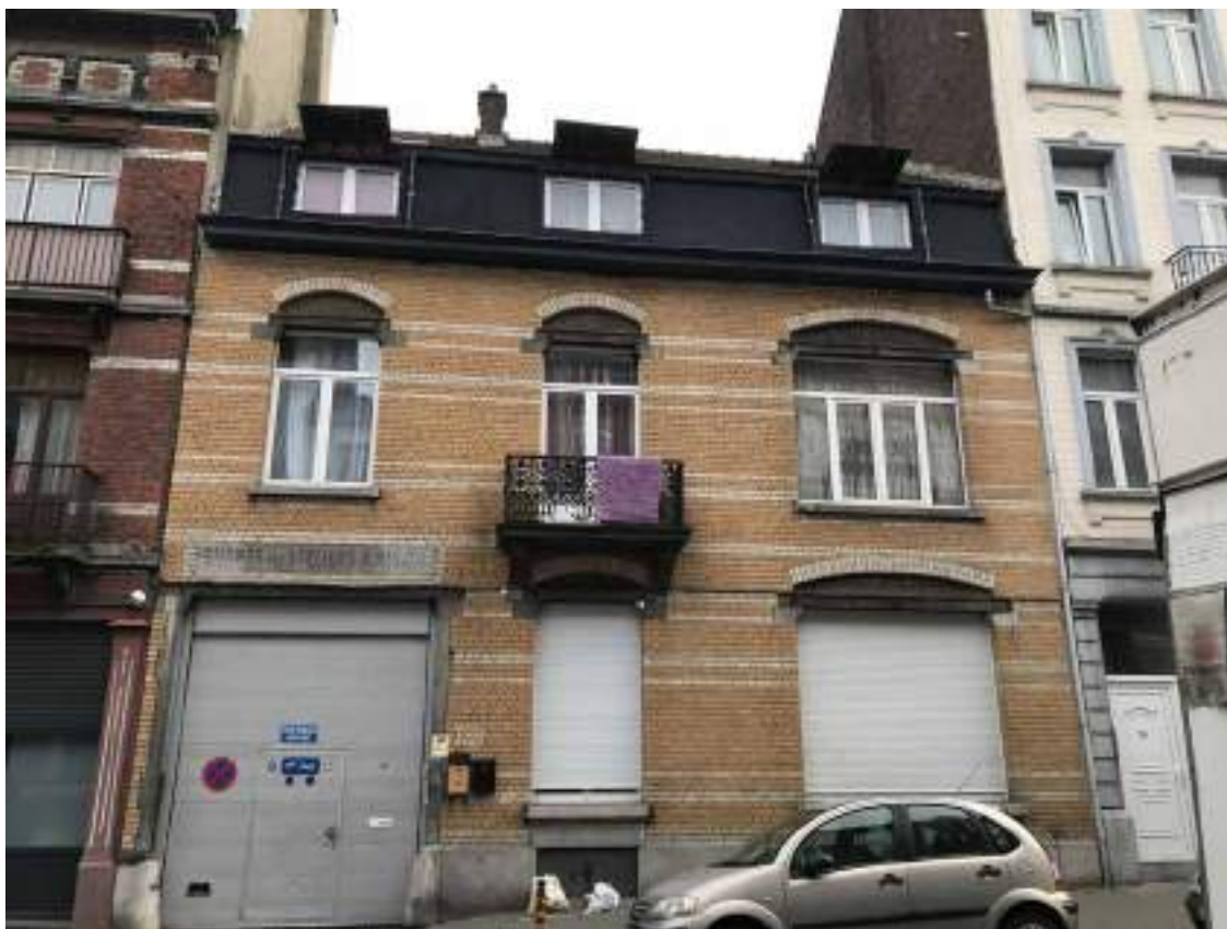
Photos de la situation actuelle des deux bâtiments.
