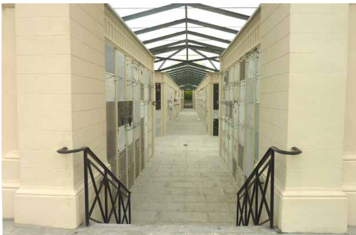
Une verrière neuve recouvre désormais l'ensemble des galeries.
