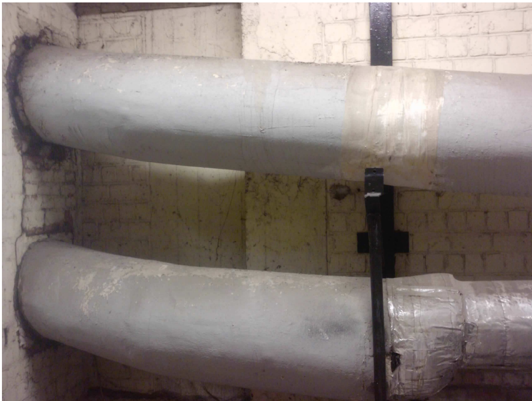
Crèche Reine Fabiola, chaufferie, calorifugeages des tuyaux photo 4
