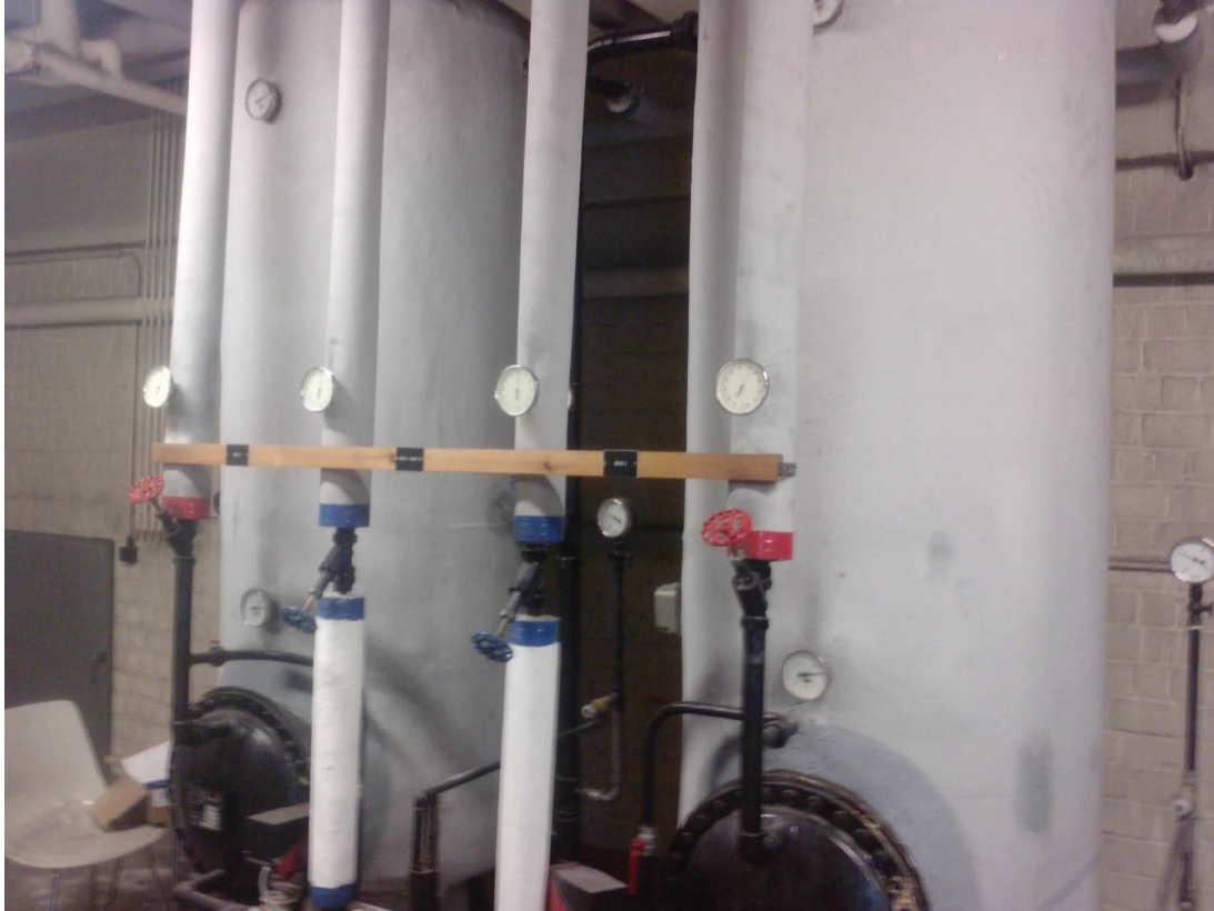
Crèche Reine Fabiola, chaufferie, calorifugeages des tuyaux photo 7
