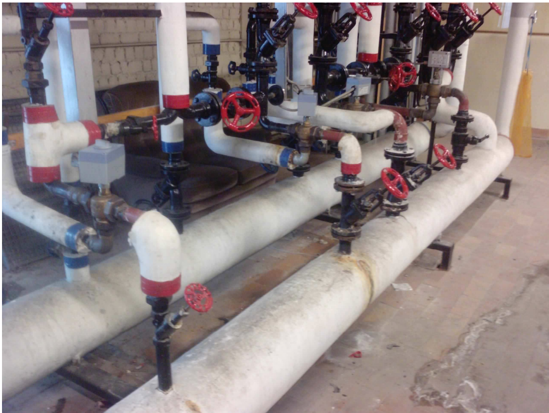
Crèche Reine Fabiola, chaufferie, calorifugeages des tuyaux photo 5
