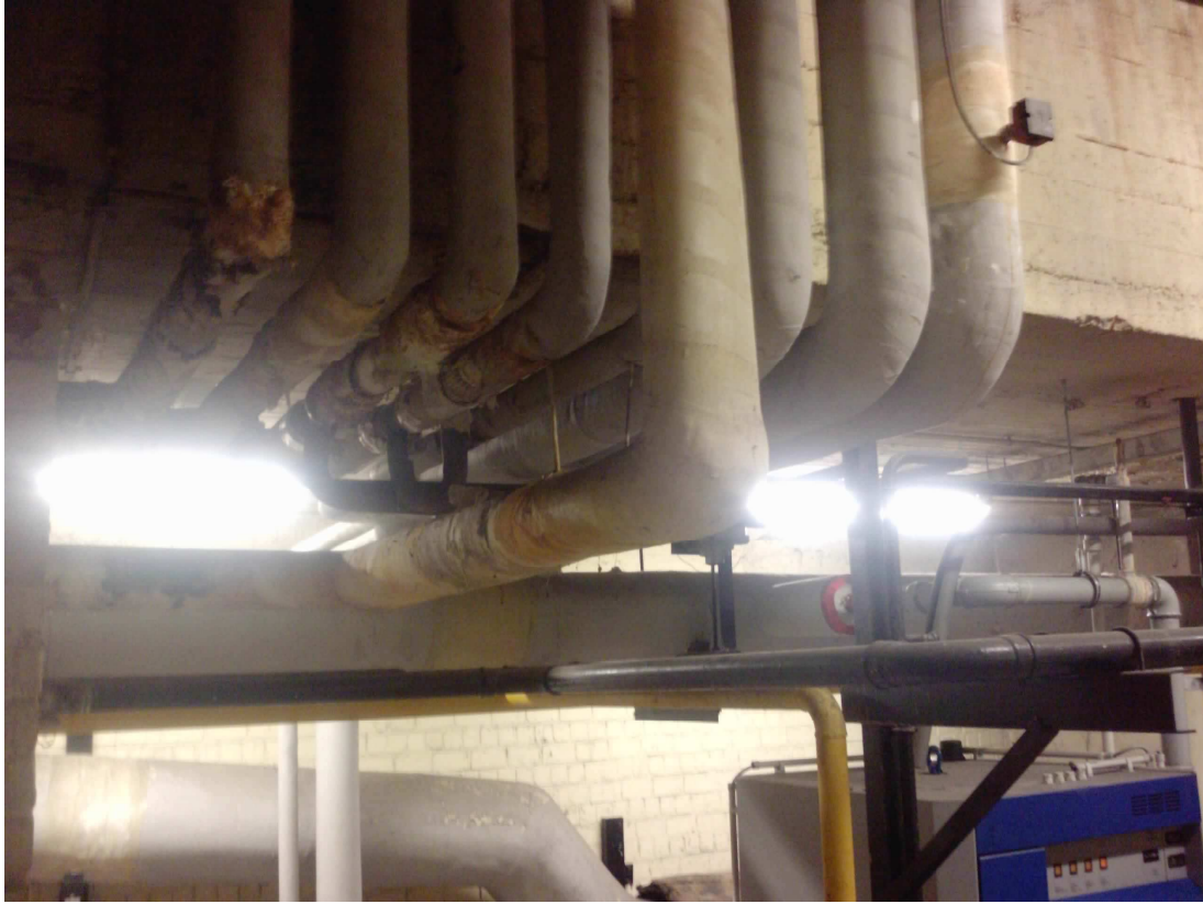
Crèche Reine Fabiola, chaufferie, calorifugeages des tuyaux photo 5
