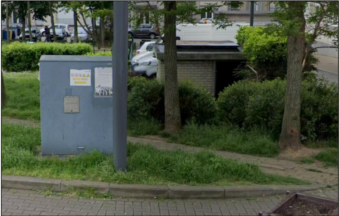
(foto elektriciteitscabine en grondwaterwinning – Google Streetview)
