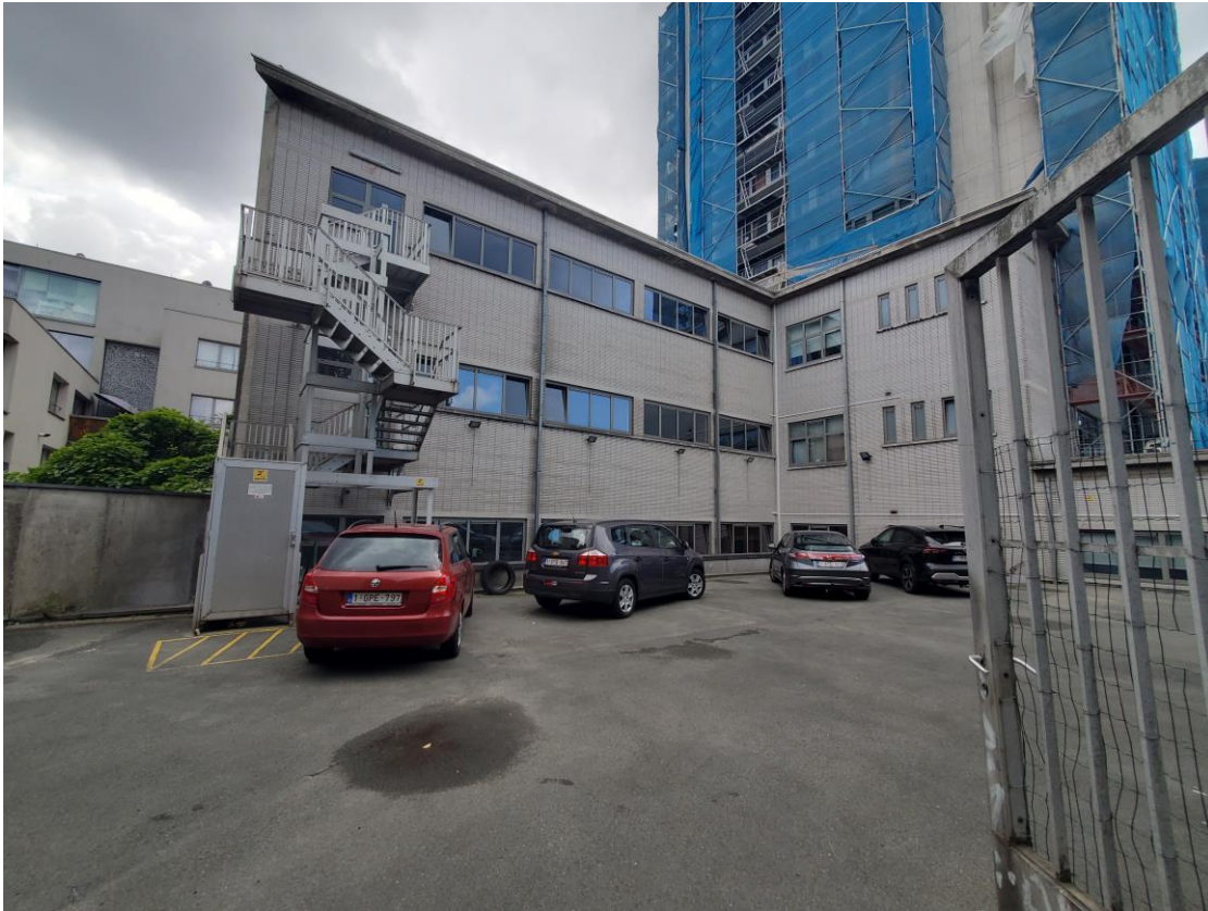
Entrée via la Rue de la Lys (parking non compris dans l'occupation)
